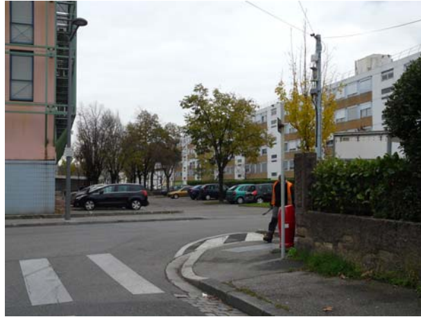
Stationnement en pied d'immeuble – Egis-1-12-2015
