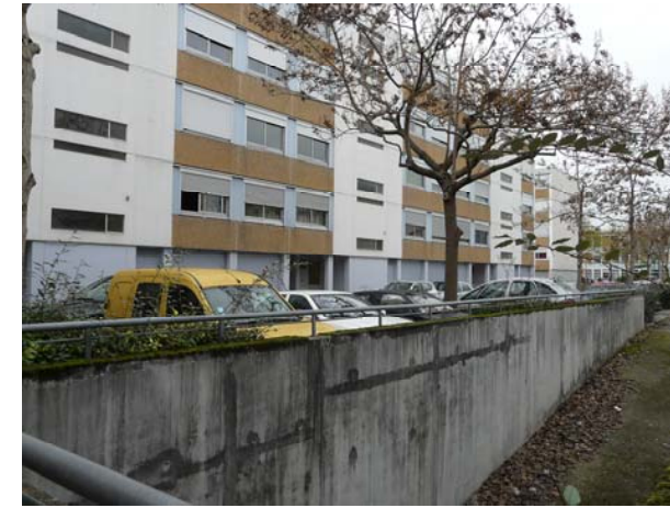
Stationnement en pied d'immeuble rue Albert Morel – Egis-1-12-2015
