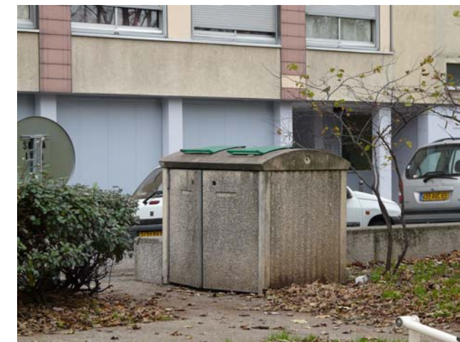
Logettes extérieures – Egis – 1-12-2015
