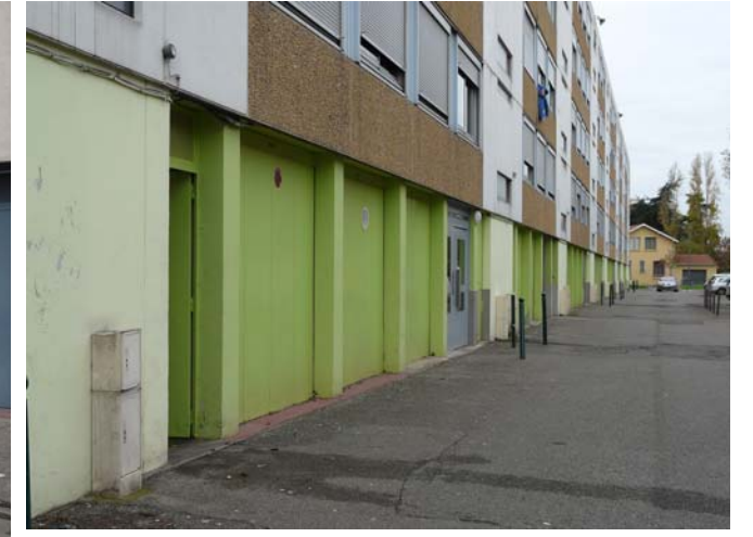
Garages en rez-de-chaussée – rue Joseph Chalier - Egis-1-12-2015
