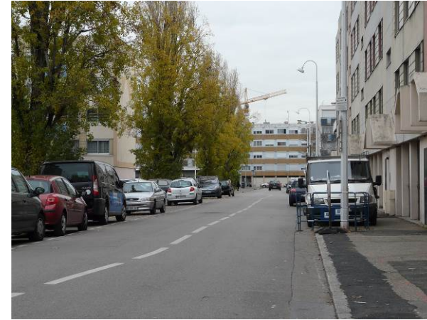
Rue Joseph Chalier en direction de la rue de Narvik - Egis-1-12-2015
