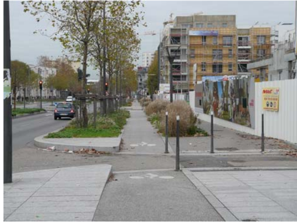
Piste cyclable et cheminement piétons sur l'avenue Jean Mermoz – côté Nord - Egis-1-12-2015
