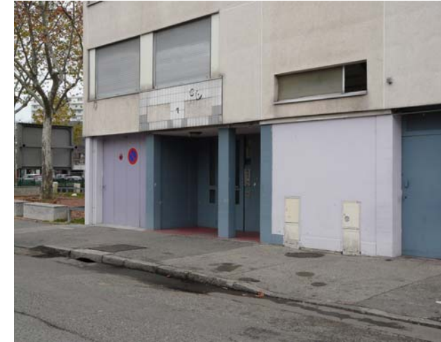
Garages en rez-de-chaussée - Rue Albert Morel - Egis-1-12-2015
